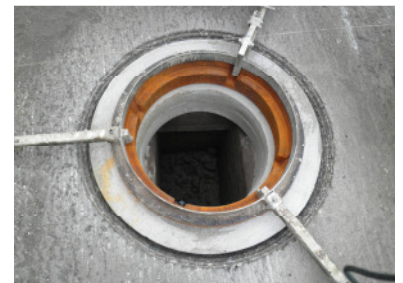
Door middel van een speciaal frame wordt de afdekking op de exacte hoogte gesteld.
