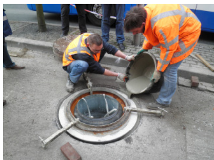
Vastzetten met sneldrogende, vezelversterkende mortel.
