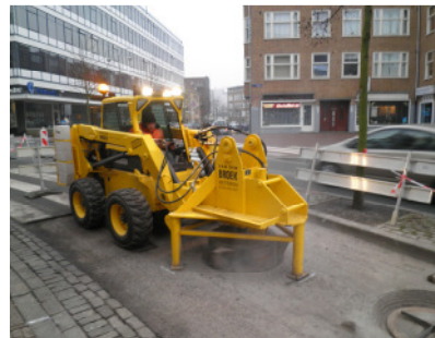
Door middel van een speciaal frame wordt de afdekking op de exacte hoogte gesteld.
